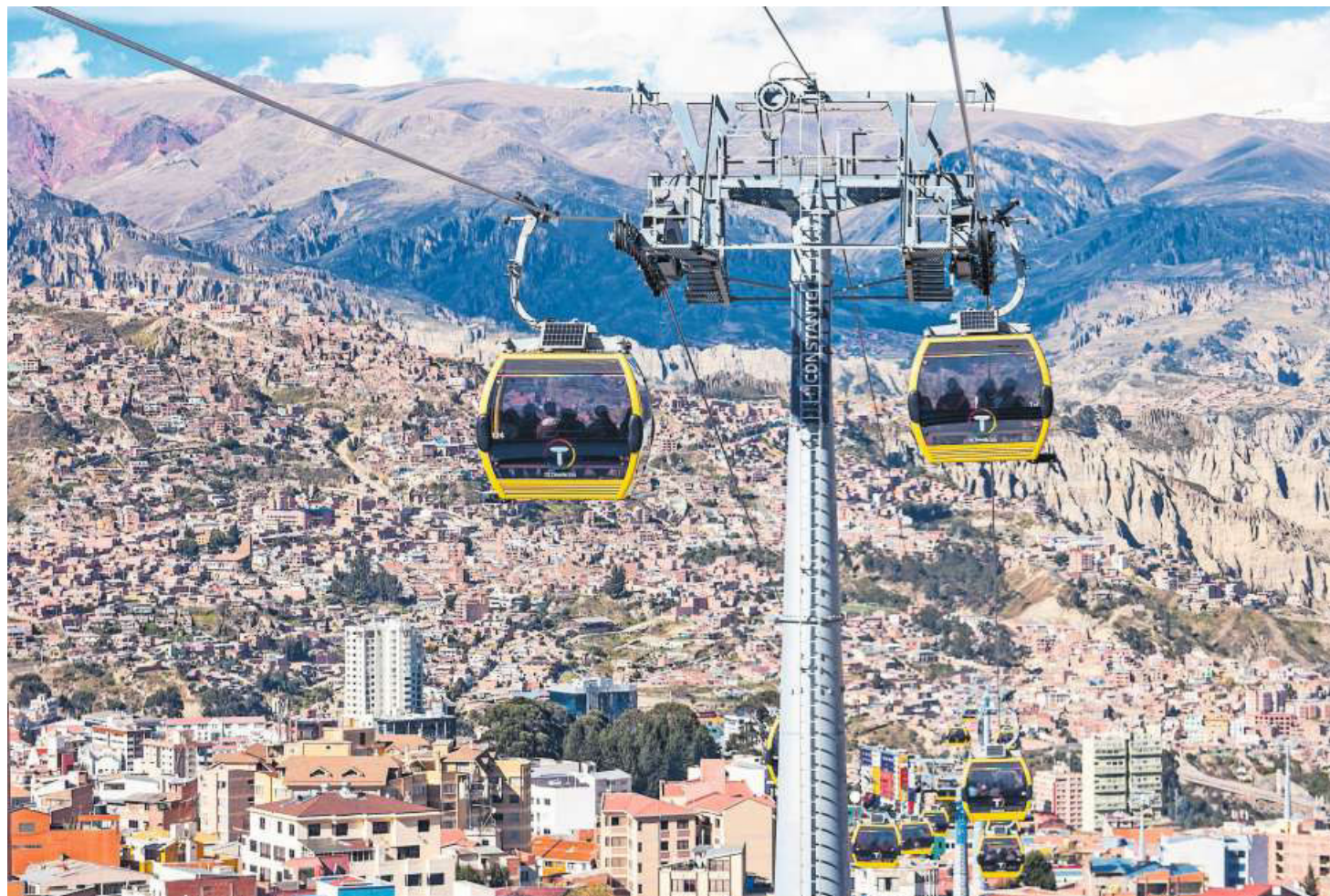
Gondeln an Stahldrahtseilen der Romanshorer Fatzer AG in der Altiplano-Hochebene der Anden in Bolivien.
